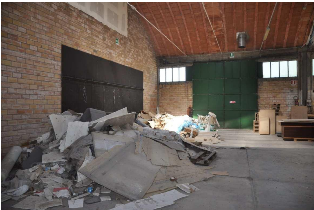
Particolare interno capannone non ricostruito
