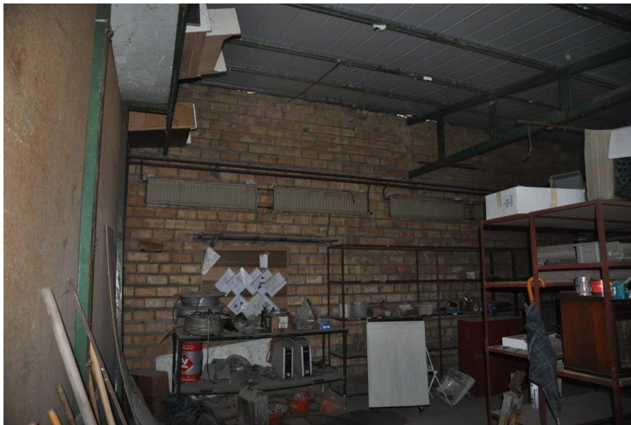
Locale tecnico accessorio
