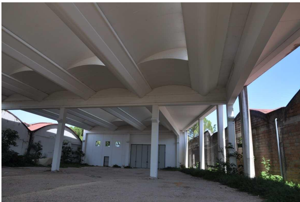
Particolare interno capannone ricostruito
