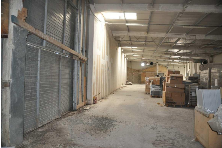
Particolare interno magazzino
