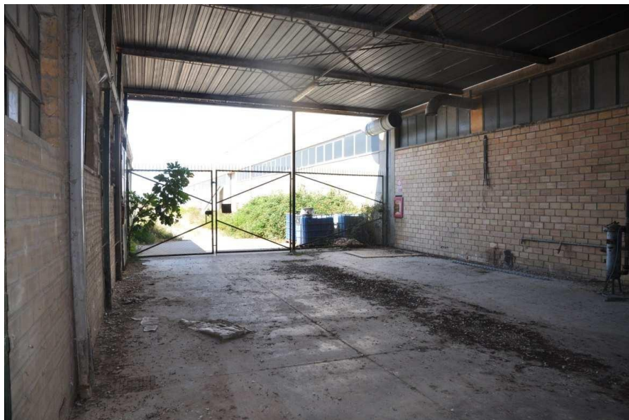
Particolare interno tettoia
