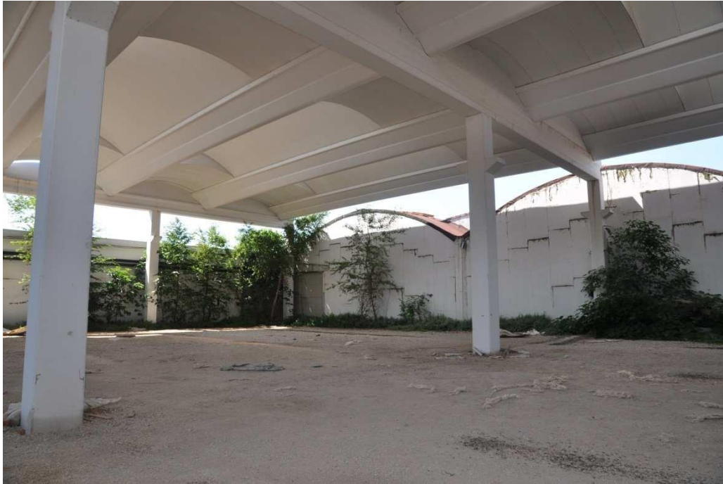
Particolare interno capannone ricostruito
