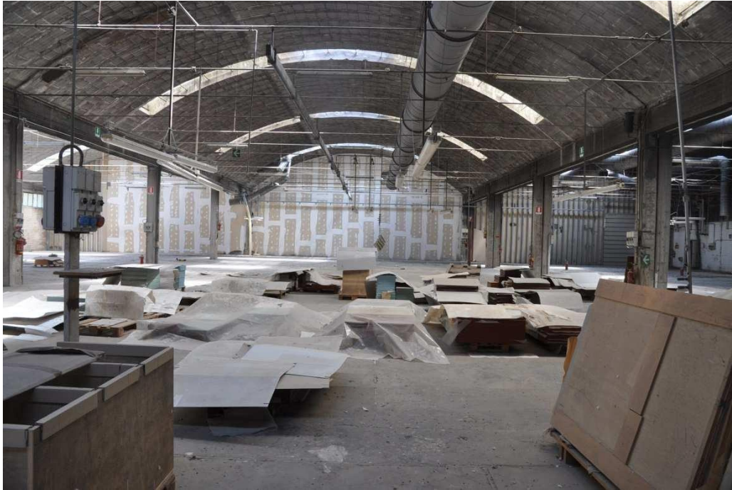
Particolare interno capannone non ricostruito
